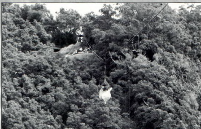
Tout l'équipement, y compris les groupes électrogènes, a dû être hissé sur l'île au moyen d'une petite grue et un astucieux système de cordes.
