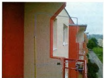
Obr. 4. Jednoduché provedení celovlnného čtverce z hliníkového drátu z VNA kabelu v praxi
