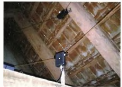
Obr. 20. Montáž balunu a zatěžovacího rezistoru na trámy
