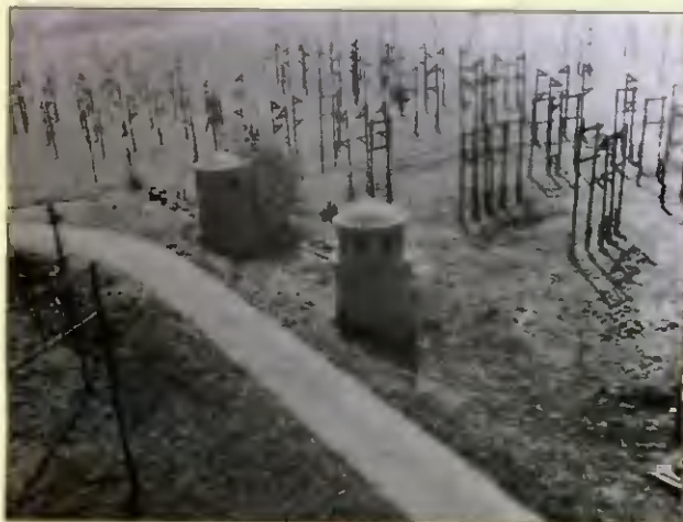
Obr. 1. Rozvody k drátovým antenám v RKS Poděbrady; ve Velvarech to bylo podobné
