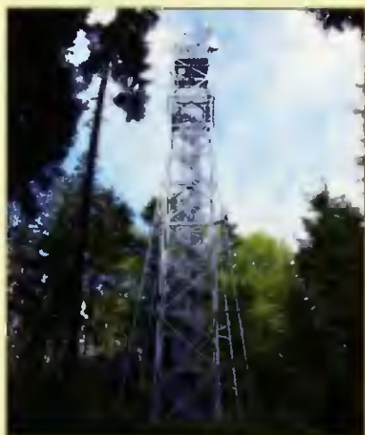
Obr. 28 Radiotelekomunikační stožár s rozhlednou na Kraví hoře dnes
