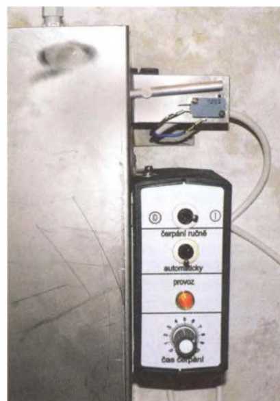
Obr. 2 a 3. Automatický spínač na boku nádrže na kondenzát
