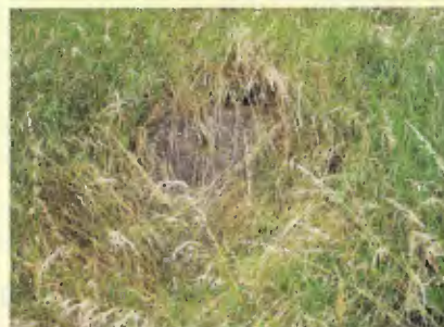
Obr. 1. Takto to vyzeralo asi pred rokom, vchod bol zakrytý panelom hrubým asi 12 cm a zasypáný zeminou, vidieť bolo iba takýto kúsok
