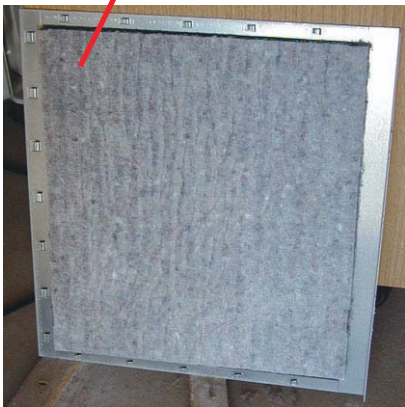
Obr. 6. Všechny krycí plechy a vnitřní stěny skříně jsou vylepeny tlumičí hmotou
