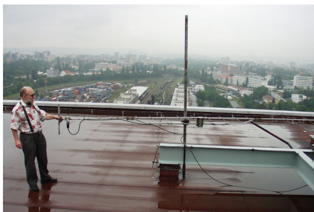
Obr. 1. OK1HH při směřování linkové antény pražského nódu OK0NC pro pásmo 70 cm, v pozadí Nákladové nádraží Žižkov
