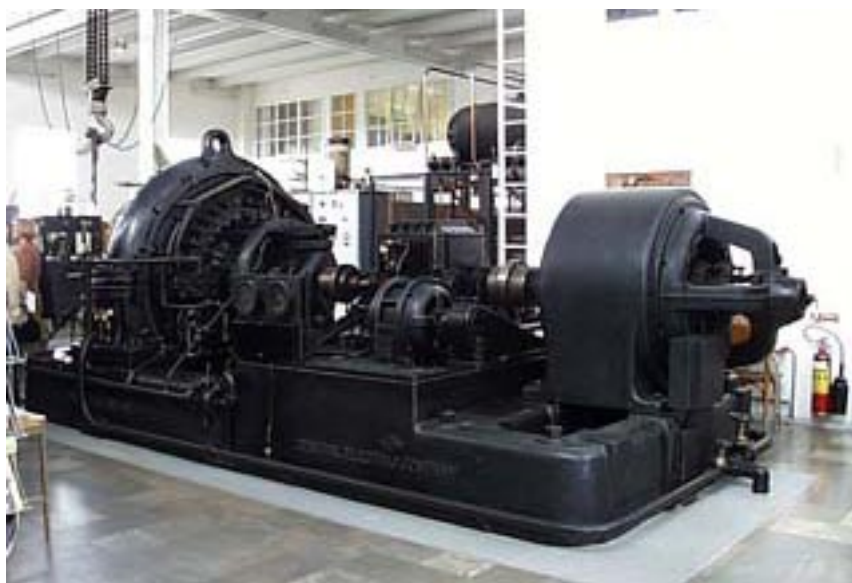
Obr. 2. Alternátor od firmy General Electric
