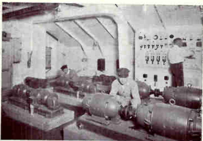
Umformeranlage für Anoden- und Heizstrom der Sender und Empfänger
