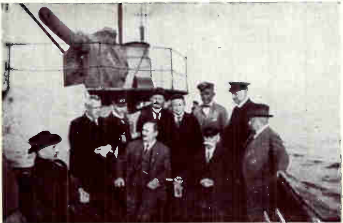
Bei der Verlegung des ersten Ostpreußenkabels 1920
