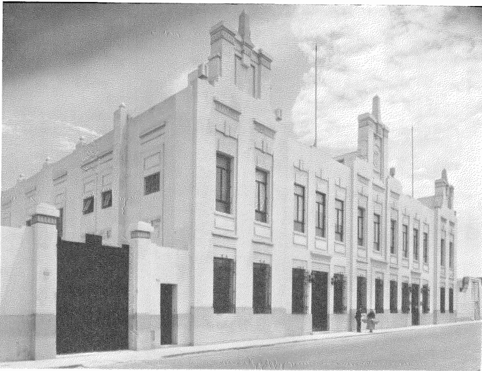
Fig. 2—Washington Automatic Exchange and Headquarters Building of the Compañía Peruana de Teléfonos Limitada.
