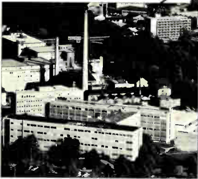
AEG-TELEFUNKEN Semiconductor factory Heilbronn Freigegeben vom Reg.-Prasidium Nordwürttemberg Nr. 2/33498C
