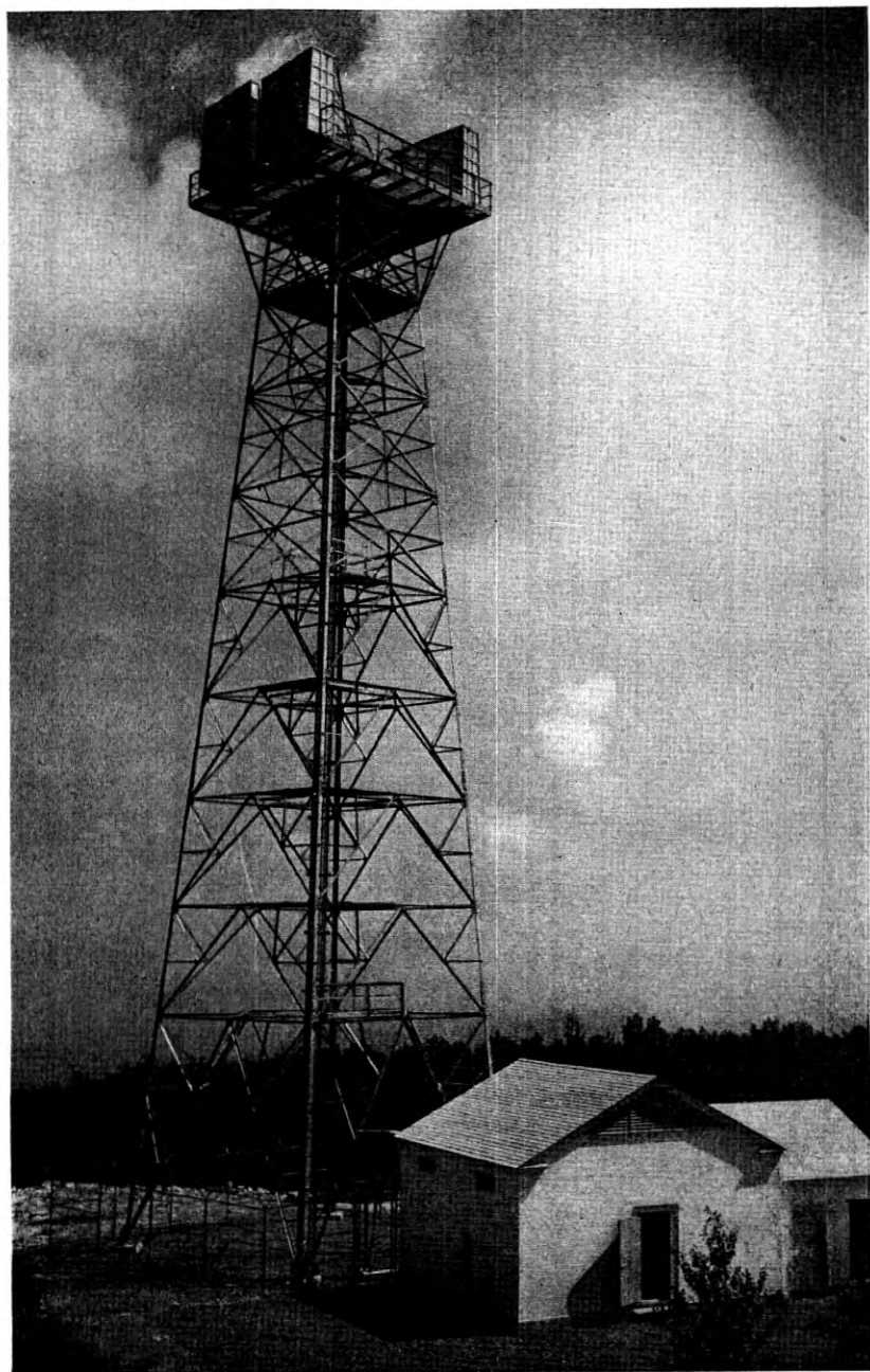
Fig. 6—125 foot steel tower.
