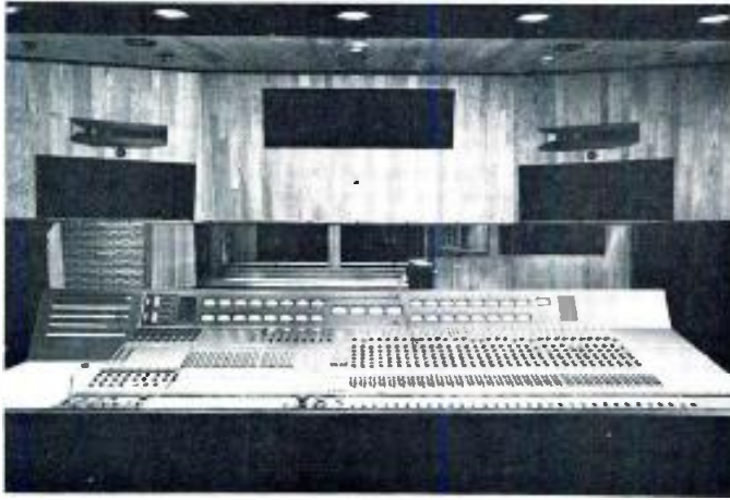
第1 スタジオ・コントロール・ルーム
