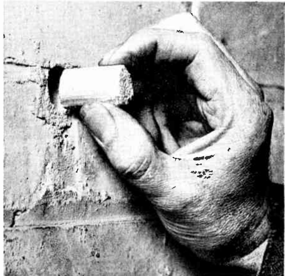
Fig. 7.—INSERTING A PLUG.
