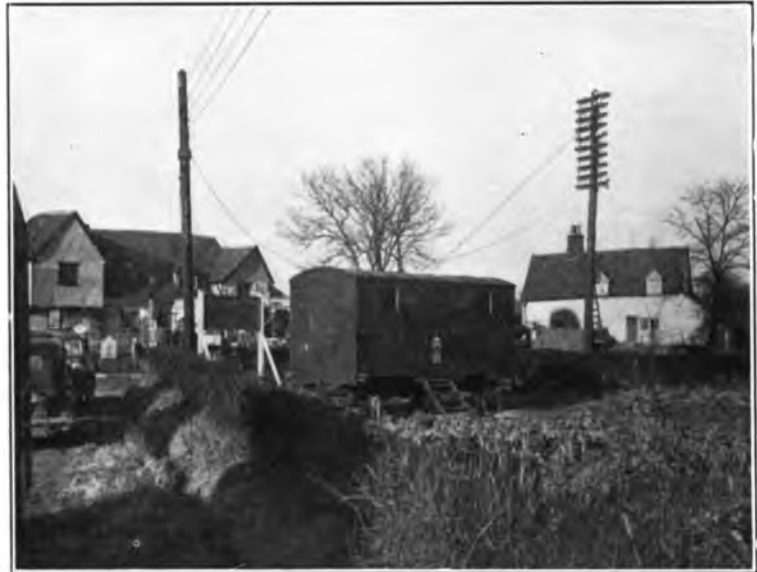
FIG. 7.—MOBILE U.A.X. ON SITE.
