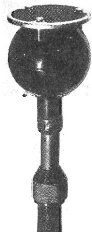
Fig. 48—S. T. & C. MICROPHONE 4021A
