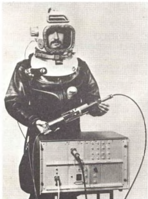
Sommozzatore accanto alle unità multiplex e demultiplex usate per trasmettere le comunicazioni vocali e per controllare costantemente le condizioni del sommozzatore tramite un cavo a singola fibra ottica.
