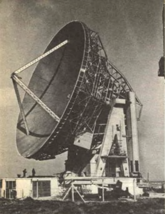
La stazione a terra di Goonhilly Downs, in Cornovaglia (Inghilterra), per trasmettere e ricevere usa un'antenna parabolica a disco orientabile da 26 m.
