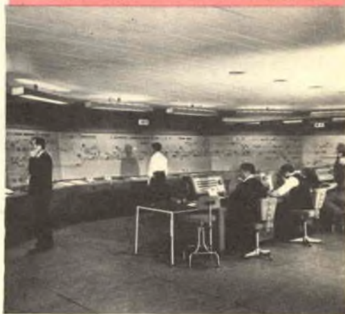
Fig. 3 - Interno della cabina di controllo di Salfley, equipaggiata con un sistema di tipo RR.
