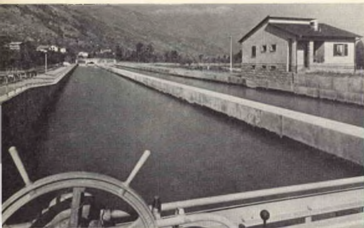
Canale derivatore all'aperto annesso all'impianto SIP di Quart. La vasca di carico in questo caso svolge pure la funzione di volano idraulico.
