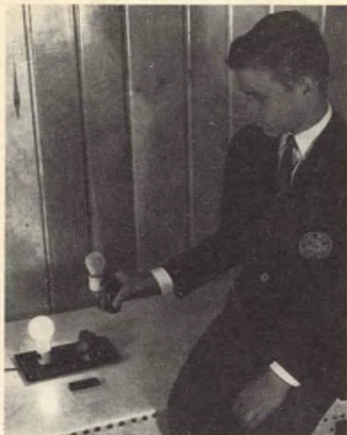
Fig. 1 - L'operatore taglia il giogo a forma di I dall'induttanza L_1 , riducendo l'induttanza della bobina e facendo di conseguenza brillare vivamente la lampada da 60 W ( I_1 ) collegata in serie.
