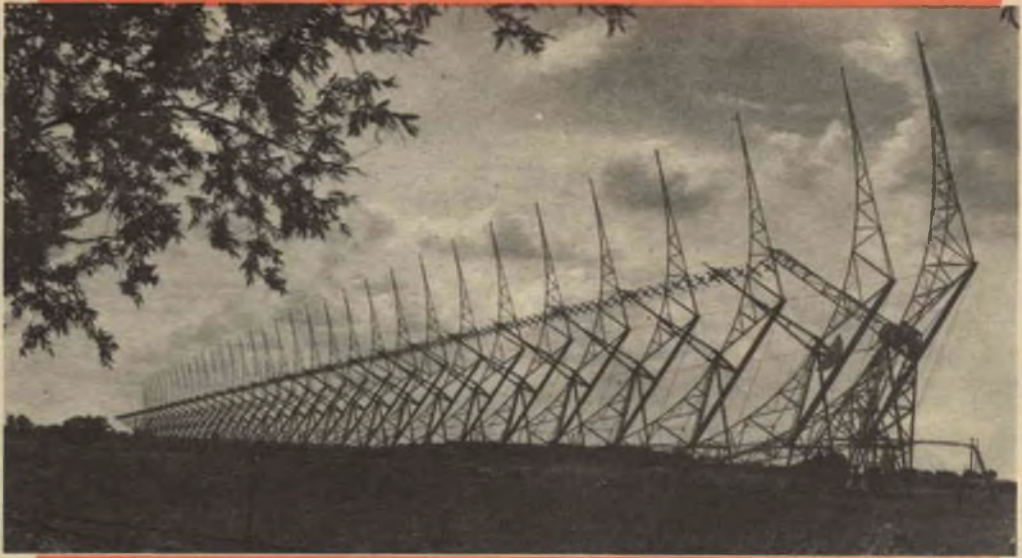
Il nuovo radiotelescopio interferometrico di Cambridge, ultimato nel 1958, aumenta il suo potere risolutivo grazie alle combinazioni di più osservazioni di una stessa sorgente fatta con diverse posizioni della parte mobile del sistema di antenne; la più lunga di esse (435 m) è fissa, mentre l'altra (57 m) è mobile su rotaia; il potere risolutivo è equivalente a quello di due antenne paraboliche da 225 m montate a 800 m l'una dall'altra. Questo telescopio avrà molti impieghi diversi.
