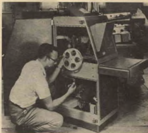
Le informazioni incorporate nell' "Autotutor" vengono raccolte su una pellicola; una qualsiasi delle 10.000 immagini può essere proiettata sullo schermo premendo un pulsante posto sul pannello frontale.
