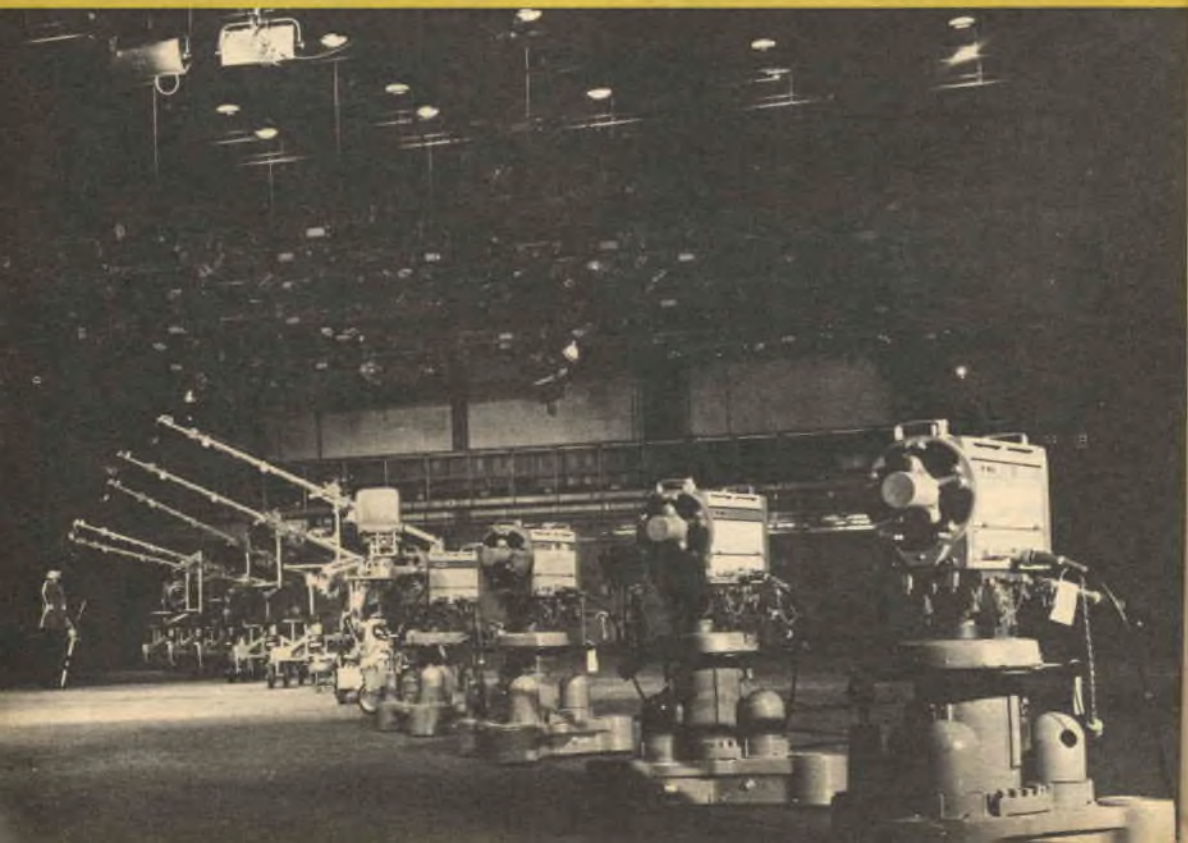
Fig. 1 - Vista parziale dell'area di produzione dello Studio N. 5 a Wembley: sono visibili le telecamere montate su carrelli a trazione elettrica e le cosiddette « giraffe » per microfono azionate a mano.
