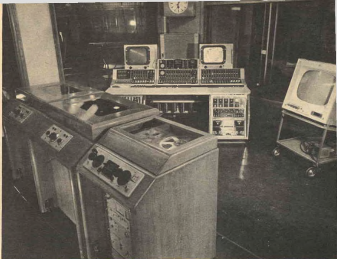
Fig. 2 - La camera di controllo del suono, con i riproduttori fonografici e a nastro in primo piano, e il tavolo di controllo contenente tutti gli amplificatori come unità inseribili.
