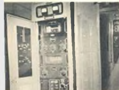
Una delle cabine dell'emettitore AME dn 5 KW.
