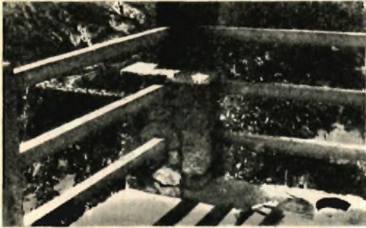
Fig. 2 - Per costruire la pergola occorre un legno di qualità, che possa resistere alle intemperie; il tipo di legno più adatto in questo caso è la quercia.
