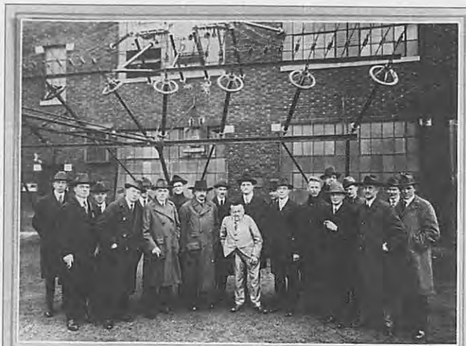
Station d'émission Marconi dans le Somerset, New Jersey 1921.
