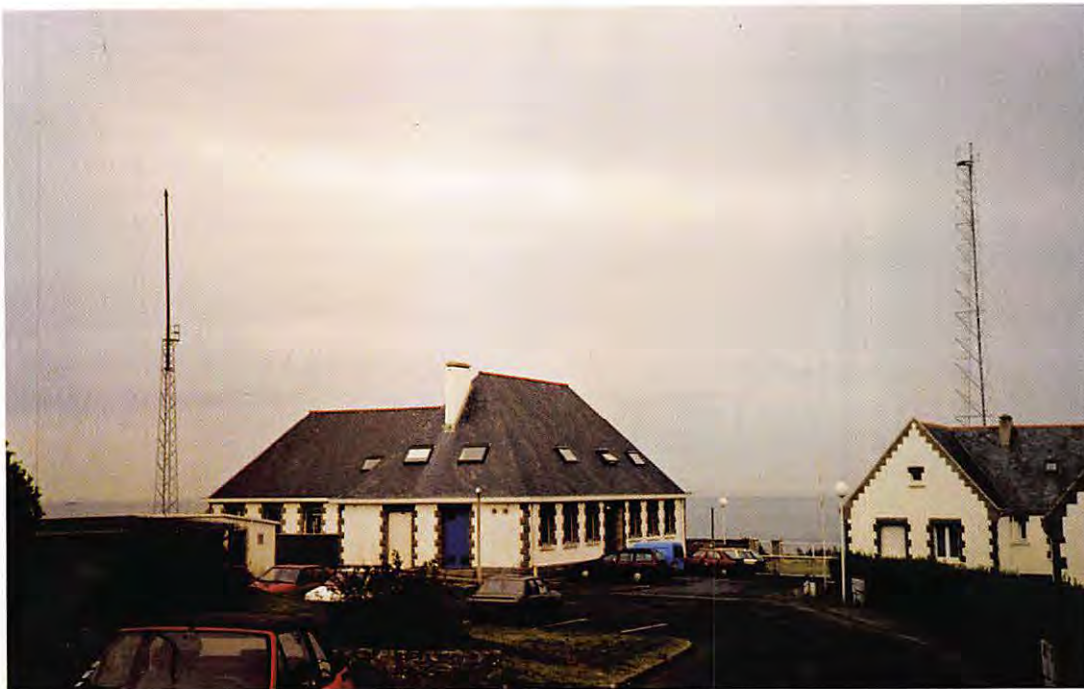
5 - Le Conquet Radio, bâtiment des opérateurs.
