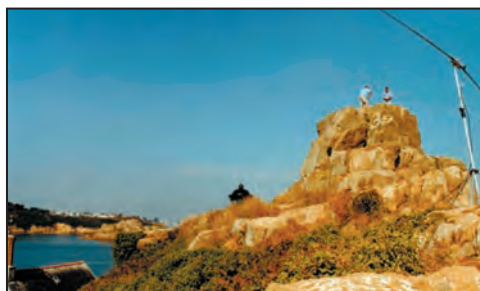
4 - Démontage de l'antenne VHF.
