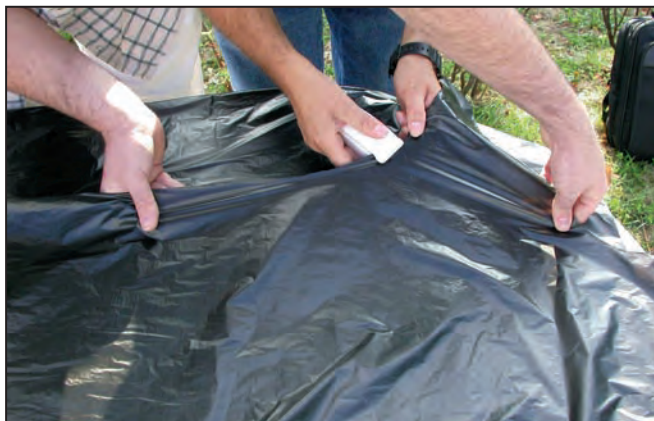
1 - Soudure à chaud du plastique de l'enveloppe.
