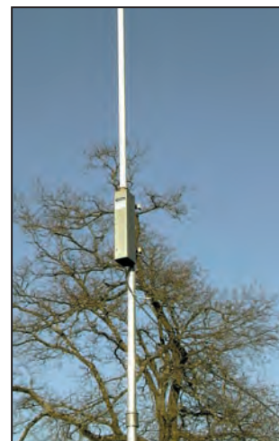
Le boîtier support, point le plus lourd de l'installation.
