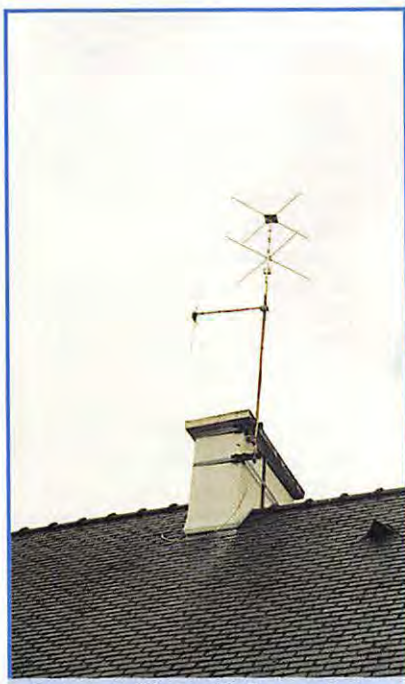
Antenne "Turnstile" pour les satellites défilants (137 MHz).
