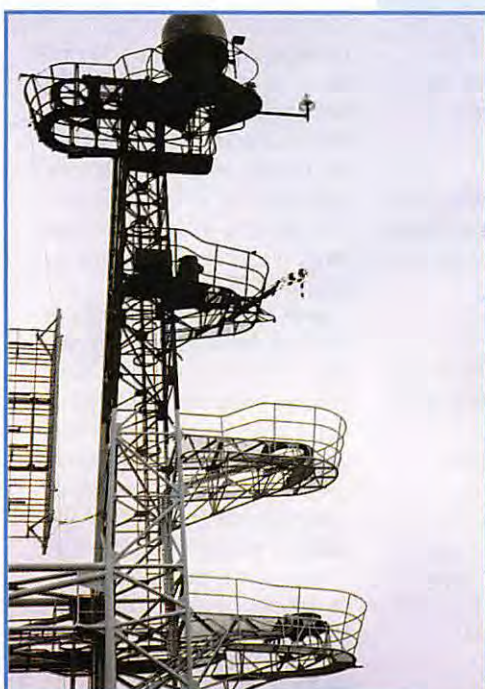
Pylône contre-mesures radar.
