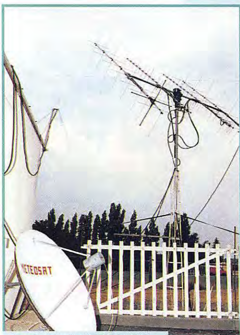
La parabole METEOSAT et les antennes de poursuite.
