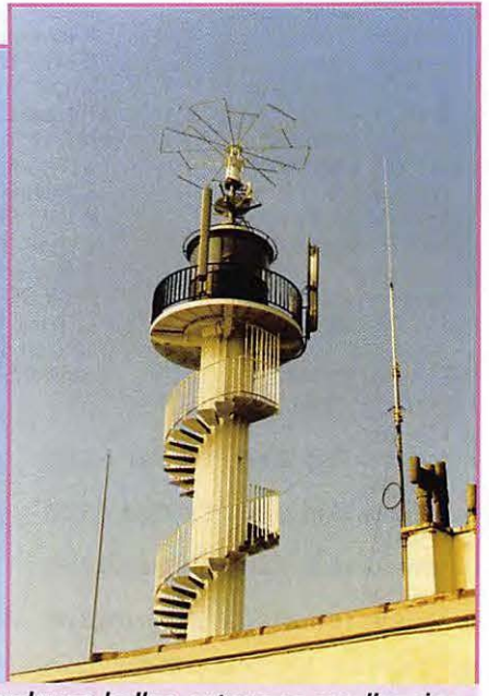
Quelques belles antennes sur l'ancien et le nouveau phare.
