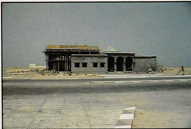
La maison de la culture en construction. Futur lieu du radioclub.
