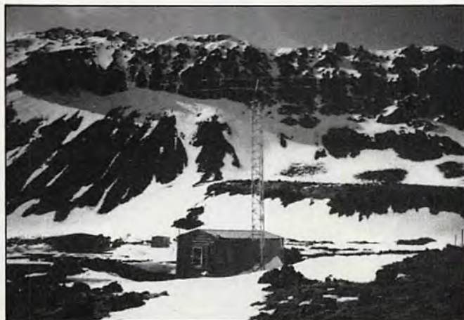
La station JX avec l'antenne "Tikkøbu" direction USA.
