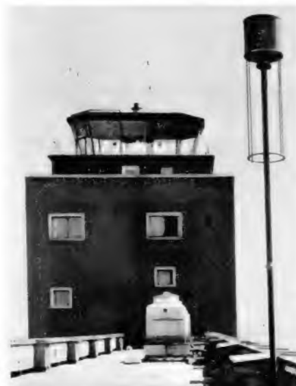
Aktive Empfangsantenne auf dem Flughafen München-Riem. Als passiver Antennenteil wurde ein doppelt gefalteter Einpol mit Dachkapazität gewählt. Zur Vergrößerung des elektrischen Gegengewichts befindet sich unter der Grundplatte ein Gitterkorb
