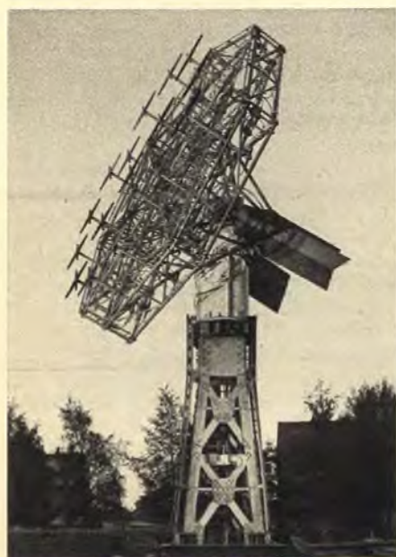
Bild 4. VHF-Spezialantennen für die unbemannt betriebenen Telemetriestationen Kevo, Reykjavik und Ft. Churchill
