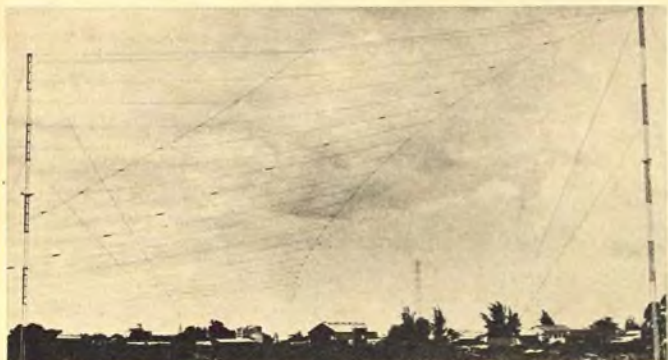
Diese 31 m hohe Richtantenne in Darassalam (Tansania) ist ausschließlich mit Parafilseilen verspannt. Aufgrund der Dehnungsfestigkeit ist ein Nachspannen kaum erforderlich (Werkaufnahme: ICI Faser-Vertriebsgesellschaft mbH)
