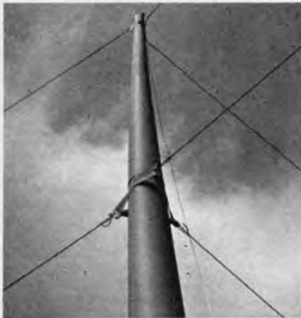
Aufblasbarer Antennenmast aus mit PVC beschichtetem Kunststoffgewebe mit zusätzlicher Dreipunktspannung
