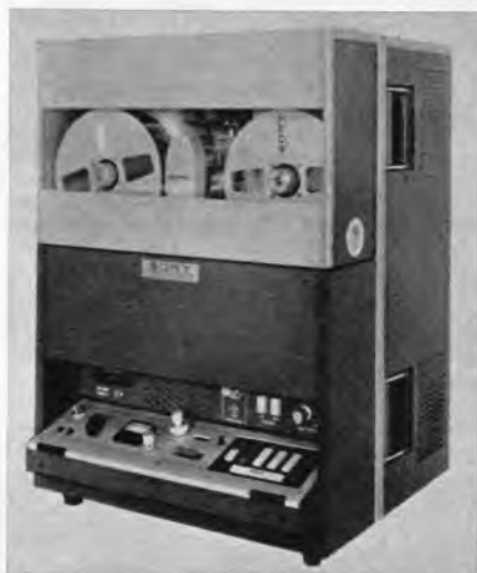
Videorecorder vom Typ PV 120 UE/BV 120 E für professionelle Anwendungen. Das Gerät erlaubt Aufzeichnungen bis zu 70 Minuten. Die Horizontalaufklärung beträgt 280 Zeilen
