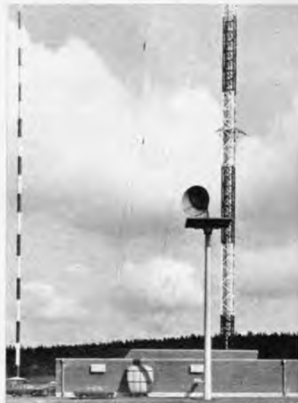
Betriebsgebäude und Sendermast auf dem Hohen Meissner. Im Gebäude stehen die Sender für das Zweite Fernsehprogramm (K 32) und nunmehr für das Dritte (K 55); der dem Hessischen Rundfunk gehörende Mast trägt die Antennen für alle drei Fernsehprogramme (K 7, K 32, K 55)
