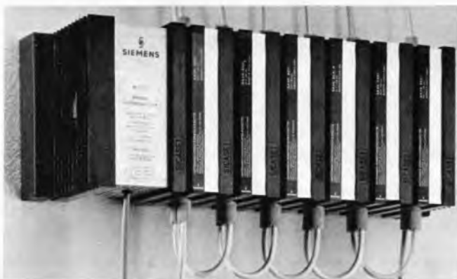
Links: Bild 7. Komplette Sicaset-Antennenverstärker-Station für LMK, UKW und vier Fernsehprogramme (Siemens)
