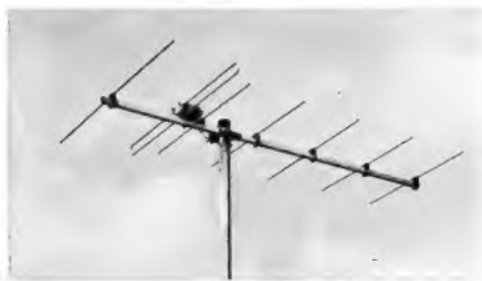
Bild 6. Falsche Montage einer Antenne: Die Anschlußdose ist oben, so daß Regenwasser in die Dose eindringen kann
