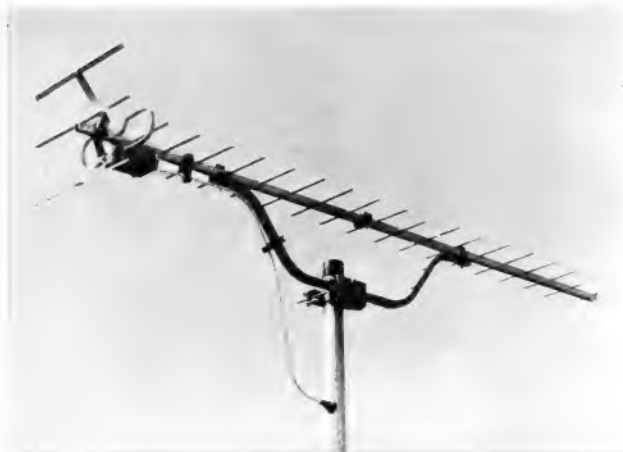
Bild 7. Das Antennenkabel ist ohne Schlaufe mit der Anschlußdose verbunden, so daß wie in Bild 6 Regenwasser in die Dose gelangen kann. Ebenso kann Wasser in den Mast gelangen, wenn dort die Tülle nicht dicht anliegt
