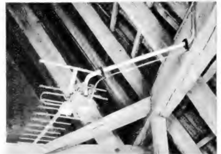
Bild 3. Mit einer Unterdachantenne lassen sich Reflexionen schon recht gut ausblenden
