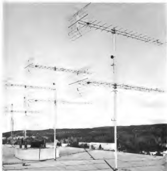
Bild 3. Vier zusammengeschaltete Mehrebenen-Antennen ermöglichen den einwandfreien Empfang eines 140 km entfernten Senders
