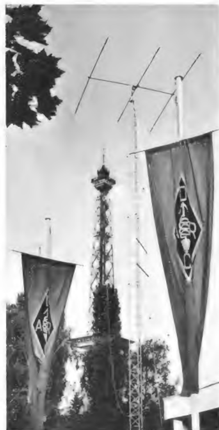
Bild 1. Die 3-Element-Richtantenne vor dem DARC-Pavillon. Seitlich am Gittermast erkennt man die 3-Band-Ground-Plane
