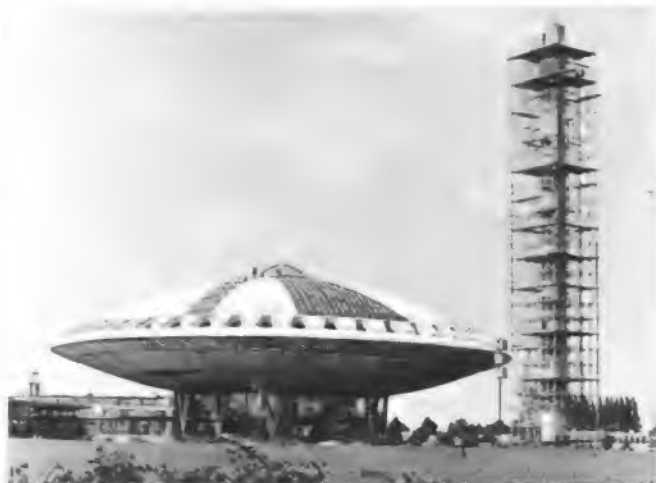
Bild 1. Das Ecoluon im Bau. Die Muschel besteht aus drei Sätzen von je 96 vorfabrizierten Betonteilen. Die flache Spitze ist eine freitragende Glaskuppel von 8 m Durchmesser
