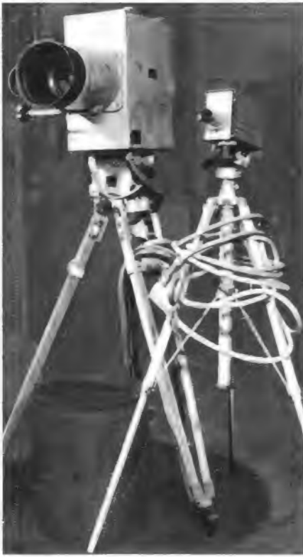
Bild 2. 1936 war das große Jahr des Fernsehens. Die 11. Olympischen Spiele fanden in Berlin statt; auf dem Reichssportfeld standen Fernsehkameras zur Direktübertragung. Links im Bild die von der Fernseh AG gebaute 180-Zeilen-Kamera mit der Farnsworth-Bildsondenröhre (Dissector-Tube). Der fernzusehende Gegenstand wurde in seiner Gesamtheit in ein Elektronenbild überführt und nach elektronenoptischer Abbildung durch zwei Magnetfelder rasterförmig über eine Bildsondenöffnung (Zerlegerblende) von der Größe eines Bildelements geleitet. — Davor steht als Vergleich ein dreißig Jahre jüngeres Grundig-Fernauge (Aufnahme: Schwahn)
