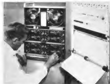
Magnetbandspeicher Modell 6100 von Saba/Precision Instrument. Rechts im Bild ein Schreiber vom Typ Beckman Dynograph
