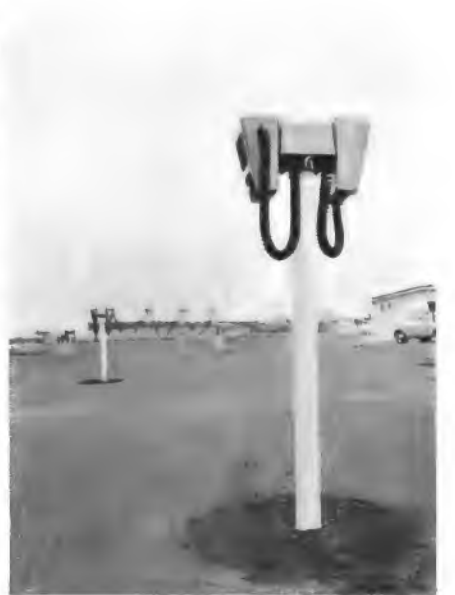
Bild 2. Eine der über 500 Säulen mit je zwei Lautsprechern, Heizlüftern und Signaleinrichtung im Berliner Autokino
