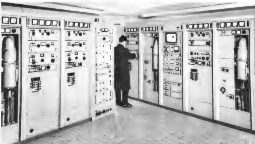
Der Mitte Mai eingeweihte Fernsehsender Hühnerberg besitzt eine effektive Strahlungsleistung von 400 kW für Bild und 80 kW für Ton. Der halbautomatische Sender, der von Siemens geliefert wurde, benötigt nur eine Person für seine Bedienung
