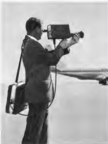
Bild 1. Die tragbare Kamera und das zugehörige Aufzeichnungsgerät der Westel Company eignen sich zum Aufzeichnen von 30 Minuten Wort und Bild
