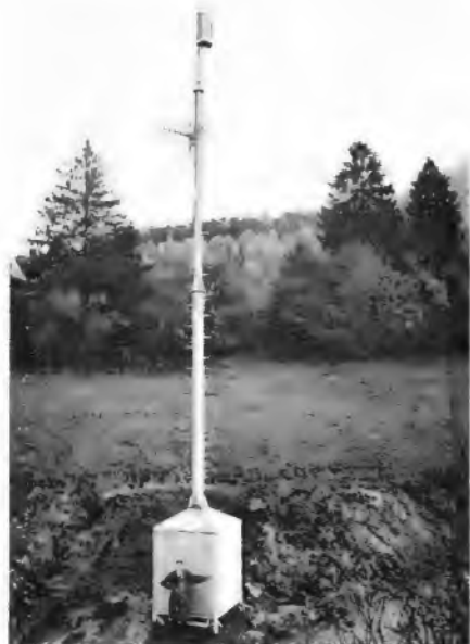
Bild 1. Mit Brennstoffzellen betriebener Fernsehfüllsender kleiner Leistung
