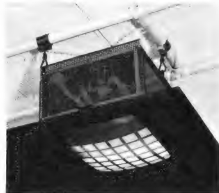
Bild 2. 59-cm-Fernsehempfänger an der Decke des Klassenzimmers umgeben von einem großen, innen geschwärzten Schirm
